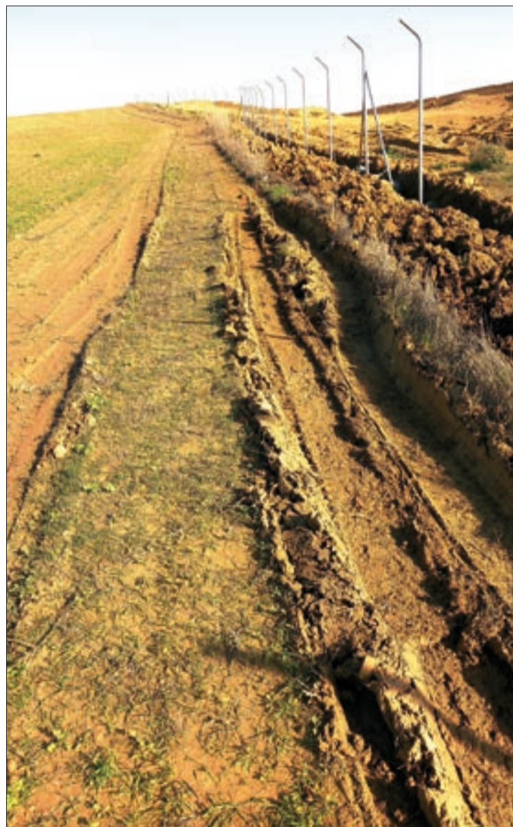
Los daños son continuos y evidentes.
