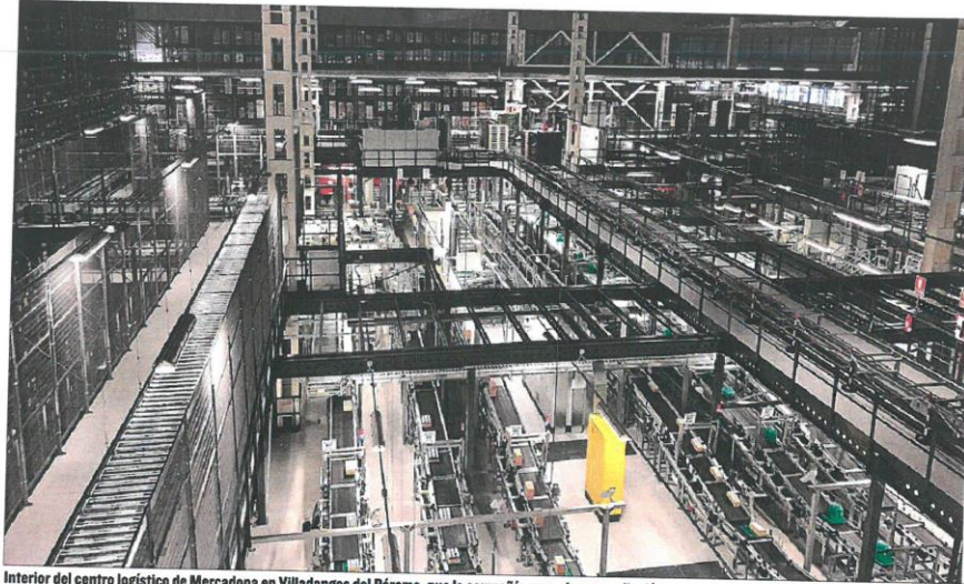
Interior del centro logístico de Mercadona en Villadangos del Páramo, que la compañía anuncia su ampliación. E.M.
